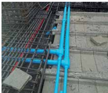
Tuberías empotradas en losa.
