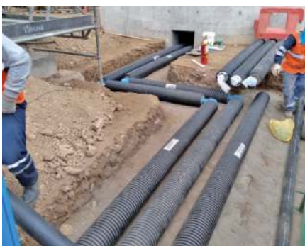
Tuberías enterradas.
