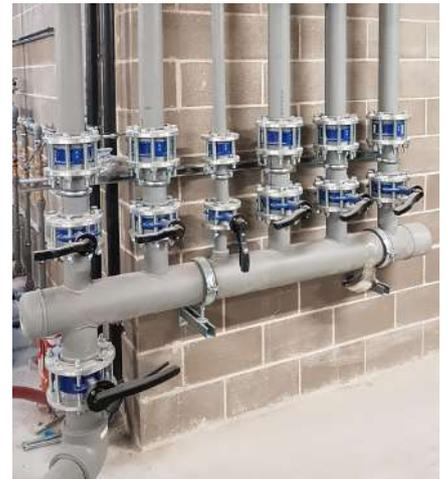
Para cumplir con las exigencias térmicas del Real Decreto y asegurar una mayor durabilidad del sistema, recomendamos la instalación de tuberías de PP-RCT con espesores mínimos correspondientes a SDR 9 y SDR 7,4. Esta elección garantiza un rendimiento óptimo y una larga vida útil en instalaciones de ACS.
