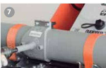
Proceda a realizar la perforación de la tubería con una broca o elemento perforador adecuado, comprobando que el diámetro de la broca y longitud es compatible con el interior de la tubería principal y de la derivación.
