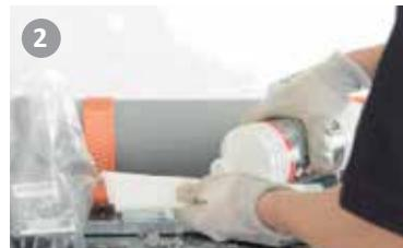
Después de raspar, elimine la suciedad y la grasa del área de soldadura de la tubería y el interior del asiento del collarín, usando un agente de limpieza apropiado. Espere hasta que las partes limpias estén completamente secas.
