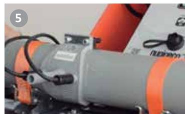
Conecte los dos cables de la máquina de electrofusión a los conectores del collar electrosoldable y siga el procedimiento de soldadura habitual para accesorios electrosoldables. Los parámetros de tiempo y voltaje siempre vienen definidos en el código de barras del collar. (Ver Manual Técnico Niron).
