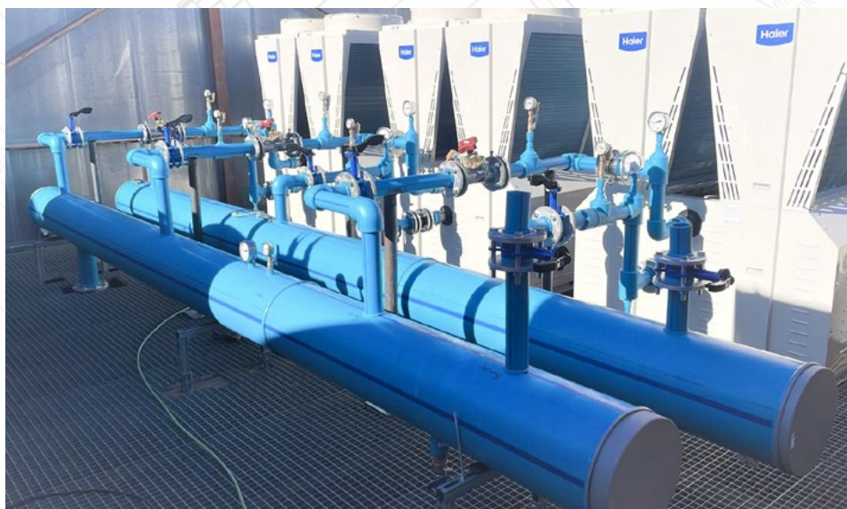
Fabricación de dos colectores PP-R NIRON en diámetro 355 mm para instalación de climatización en un hotel ubicado en Las Tablas, Madrid.
