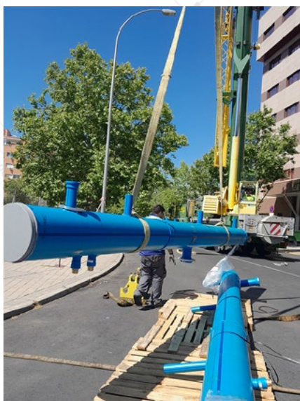
Fabricación de dos colectores PP-R NIRON en diámetro 355 mm para instalación de climatización en un hotel ubicado en Las Tablas, Madrid.
