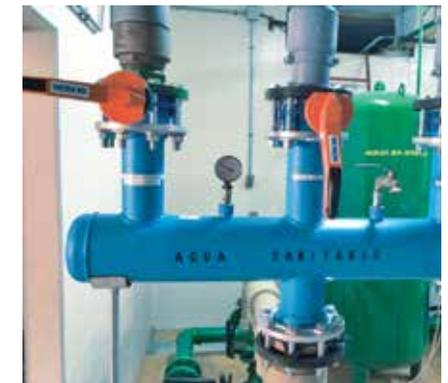
Sustitución por colector nuevo en PP-R, inmune a la corrosión.
