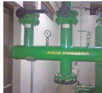
Colector a reformar por oxidación interior.
