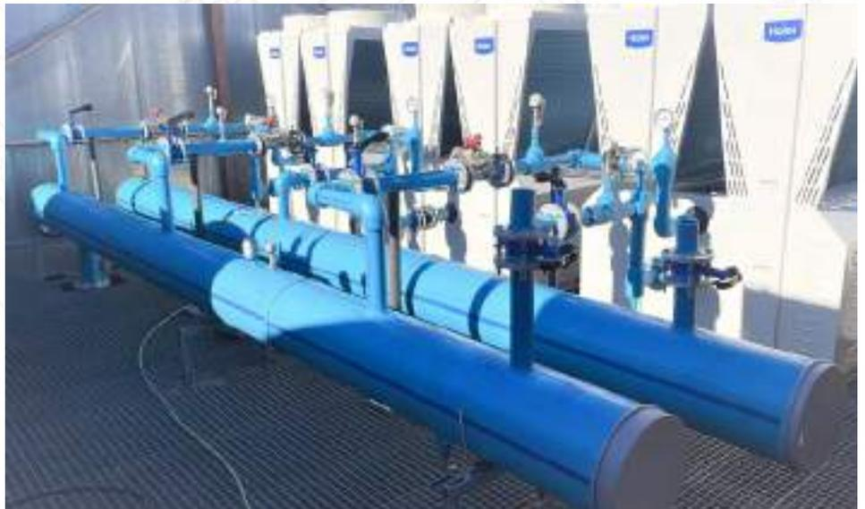
Fabricación de dos colectores PP-R NIRON en diámetro 355 mm para instalación de climatización en un hotel ubicado en Las Tablas, Madrid.
