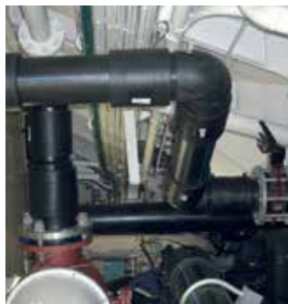
Tratamiento de aguas en buques
