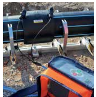
Distribución agua en zona portuaria
