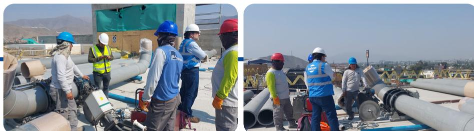
El objetivo de la charla es **conocer los tres sistemas de unión de tuberías y accesorios del Sistema NIRON**, mencionando algunos criterios teóricos y desarrollando de manera práctica los distintos pasos del proceso de termofusión, según la norma DVS 2207-11 PP:2017.
